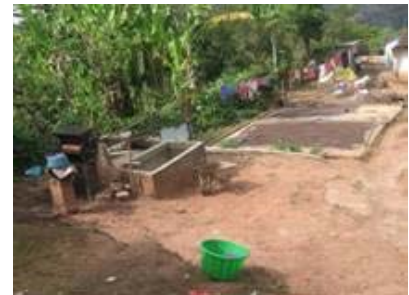
UPC e pátio de secagem destruídos antes do projeto
