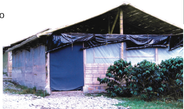
Caseta de emergencia Emergency house
